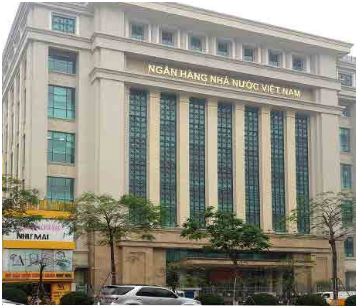
Công trình Ngân hàng Nhà nước Việt Nam Hạng mục thi công: Sơn đá nghệ thuật, Sơn trang trí
